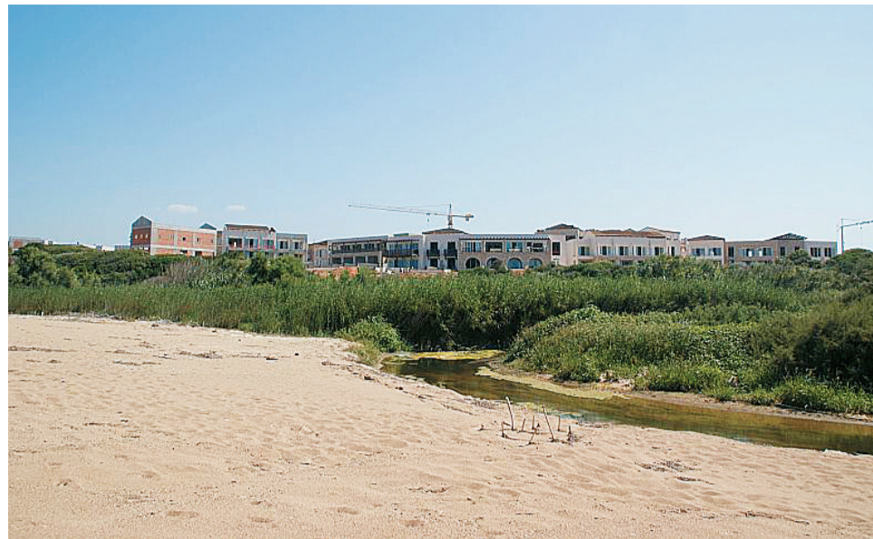
Vom sandigen Strand bei Romanos, an dem die Meeresschildkröte Caretta caretta ihre Eier ablegt, sind die Rohbauten des zukünftigen Urlauberparadieses gut zu erkennen.
