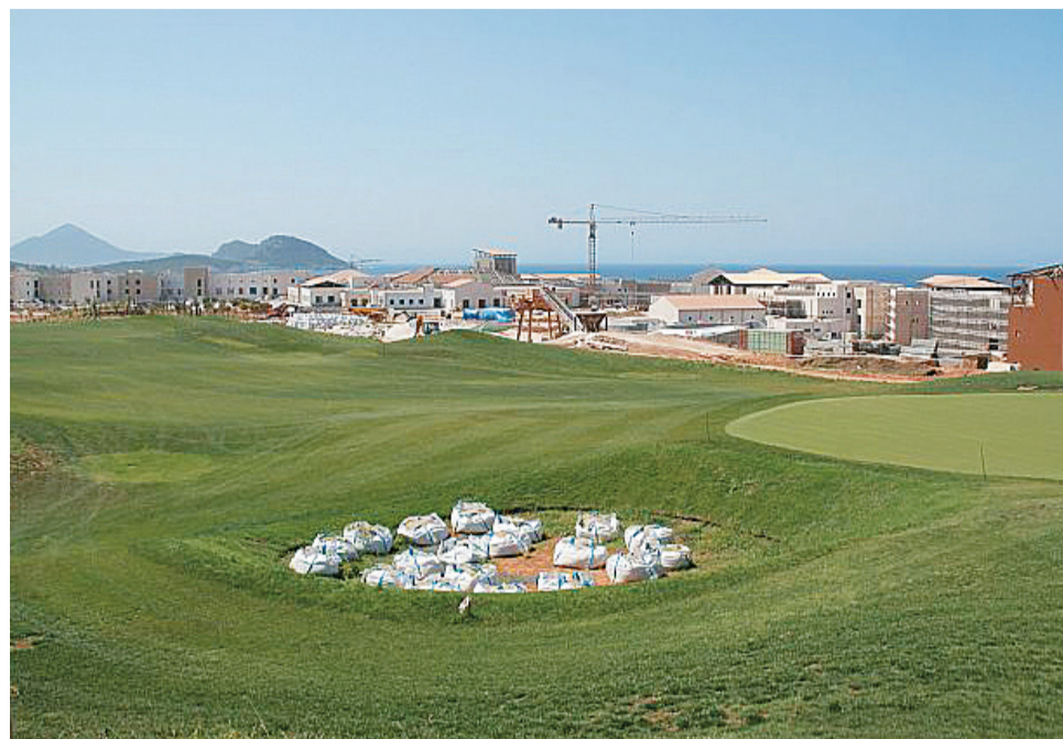
Die weißen Säcke im Vordergrund enthalten Sand für die „Bunker“ an den „Greens“; dahinter sind die Ausmaße des Golfresorts in etwa zu erkennen. Links neben dem Baukran überragt der Bibliotheksturm die restliche Kleinstadt. (Fotos: GZik)
